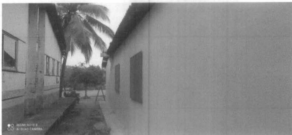
Imagem 7 – Revisão da cobertura, instalação de grades nas janelas e pintura externa da escola.
