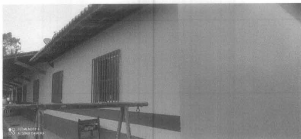
Imagem 5 – Instalação de grades nas esquadrias da escola.
