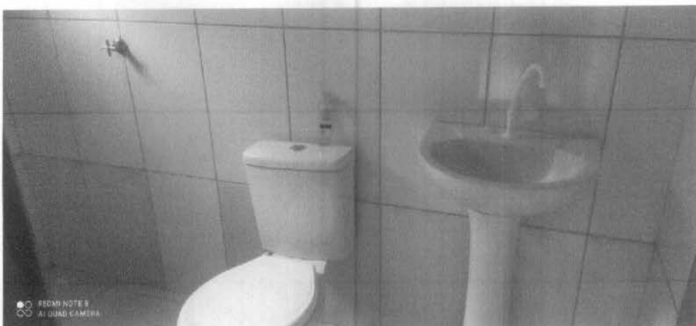
Imagem 4 – Substituição da bacia com caixa acoplada e lavatório com coluna nos banheiros da escola.
