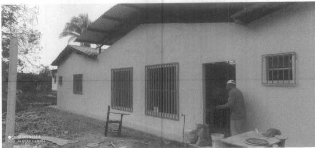
Imagem 3 – Revisão da cobertura e pintura externa da escola.
