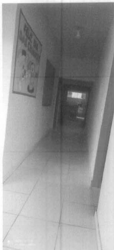
Imagem 6 – Assentamento de piso cerâmico no interior da escola e instalação do forro em pvc.
