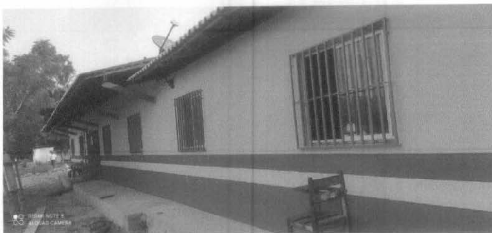
Imagem 1 – Revisão da cobertura e pintura externa da escola.
