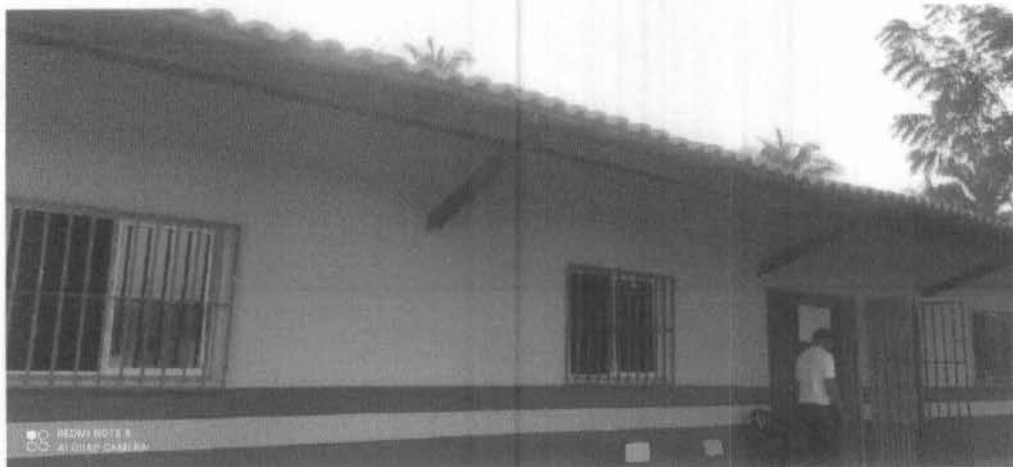
Imagem 2 – Revisão da cobertura e pintura externa da escola.
